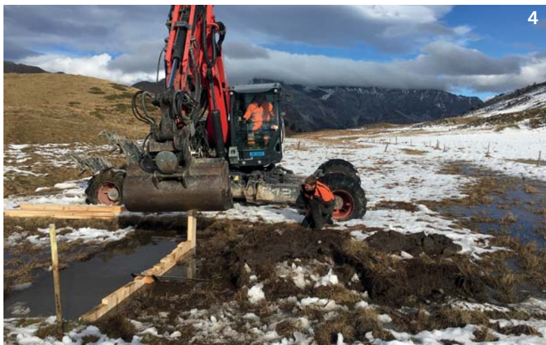
Die Stautafeln aus Holz werden mithilfe eines Baggers eingebaut. (Markus Camastral)
